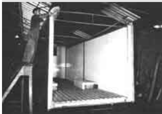
Wärmegeprägter Aufbau in moderner Sandwich-Modul-Bauweise (1957)
